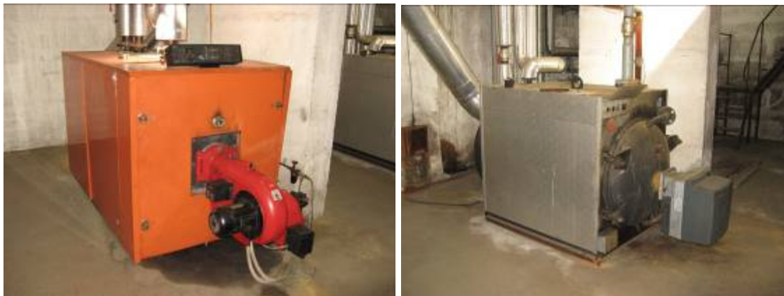
Slika 4: Kotla v kotlovnici na Kajuhovi ulici 2
