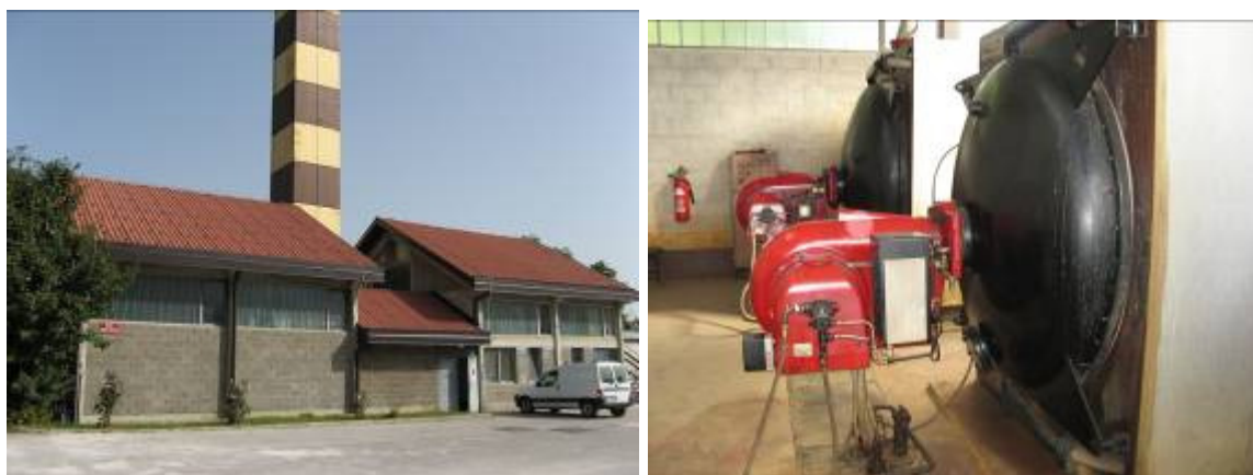
Slika 3: Skupna kotlovnica za ogrevanje stanovanjskih objektov na ulici Toneta Melive
