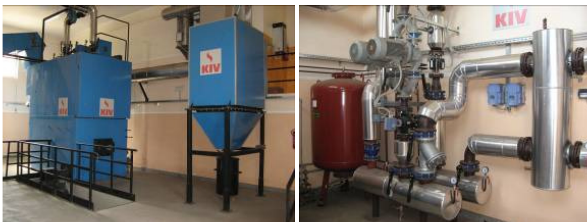
Slika 12: Kotel in kotlovska instalacija
