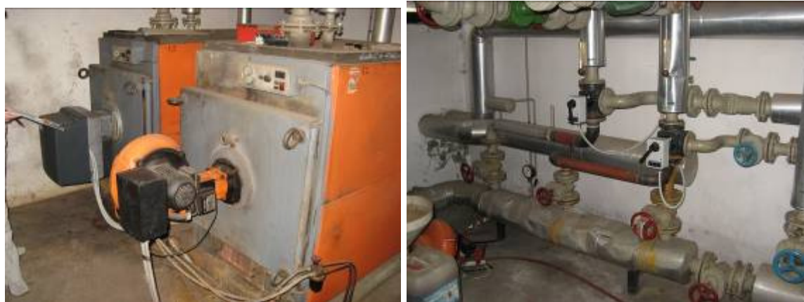
Slika 5: Kotla in kotlovska instalacija v kotlovnici – Kajuhova 1
