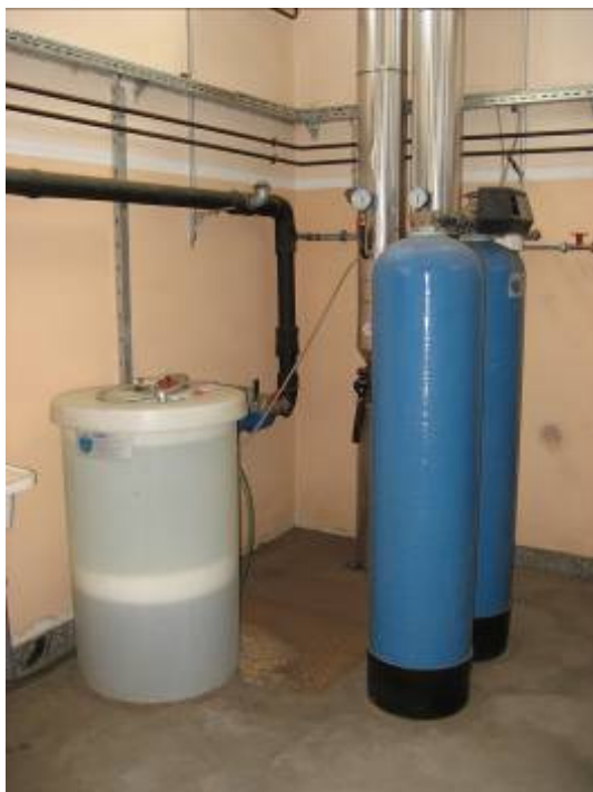
Slika 13: Priprava vode za ogrevalni sistem
